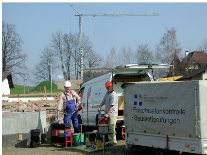
Frischbetonkontrolle auf der Baustelle
