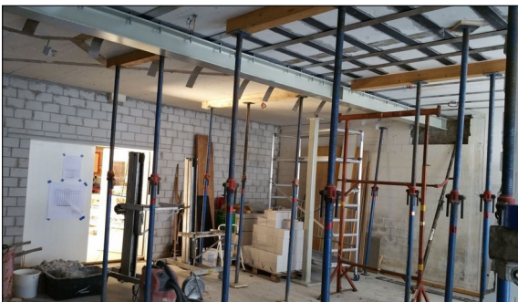
Ausgeführte Verstärkungsmassnahmen für die Decke der Zimmerei mit CFK und SMA-Lamellen [Quelle: Markus Keller, Bauherr]
