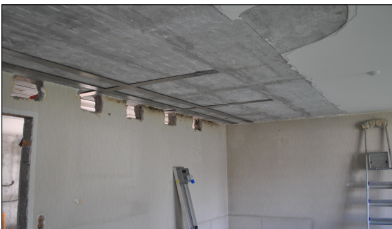
Verstärkung einer Stahlbetondecke in Brunnen SZ mit den neuartigen SMA-Lamellen, [Quelle: Stefan Manz]
