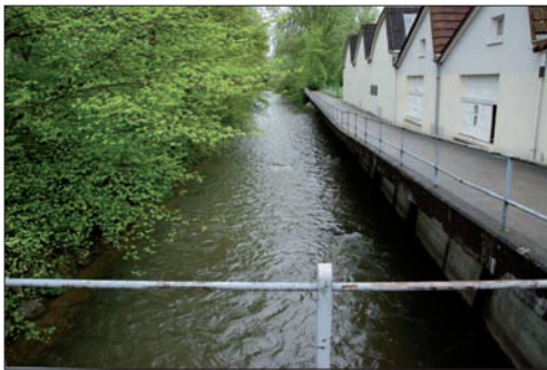
Foto vom Bleichesteg aus gegen die Fliessrichtung: ungenügender Freibord und keine ufergerechte Verbauung
