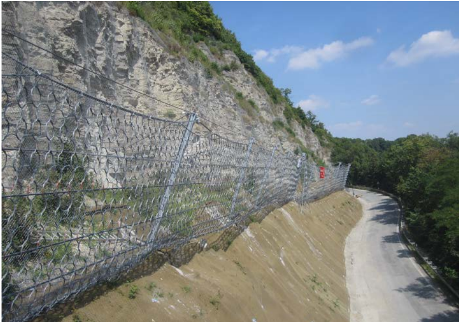
Steinschlagbarriere, eine Sicherungslösung, wie es Geobrug AG im Produktportfolio aufweist. © Geobrug AG
