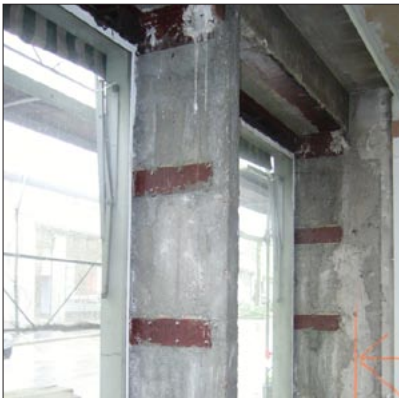
Bestehende Stützen Westfassade
