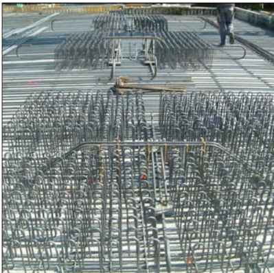
Durchstanzelemente bauseits verlegt
