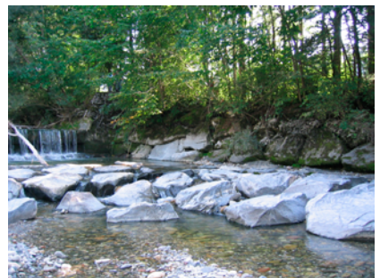
Bild 2: «Römerstrasse» (grobe Blöcke) zur Sicherung von Längs- und Querbauwerken
